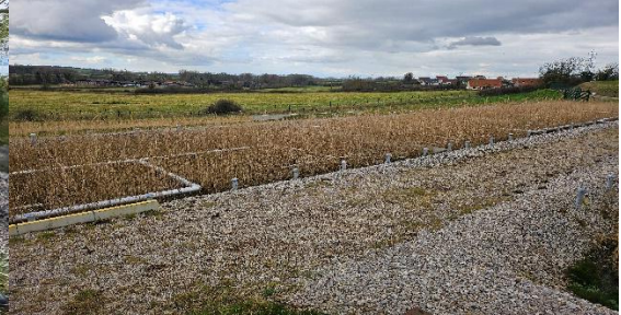
Station d'épuration d'Hardinghen (950 eh)
