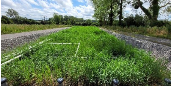
Station d'épuration de Le Wast (300 eh)
