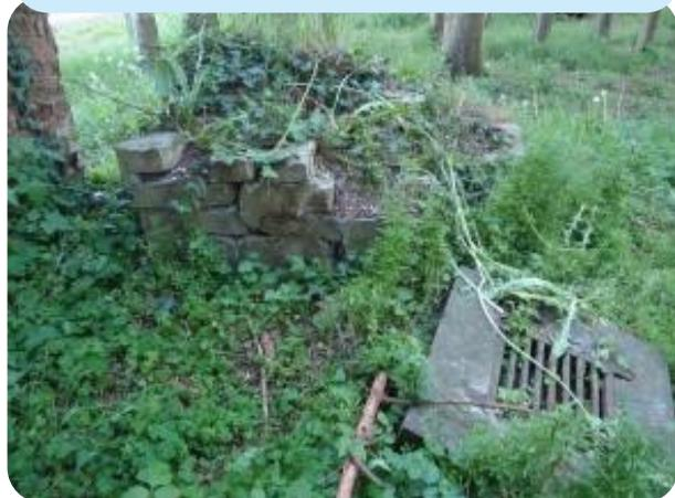
La structure de la chambre de visite permettant l'accès au réceptacle de source avec drains est à réhabiliter suite à des défauts importants de la structure, à un manque d'étanchéité et à l'absence de sécurisation des accès. La protection multi-barrière permettant de retarder l'accès à l'eau est quasiment inexistante.
